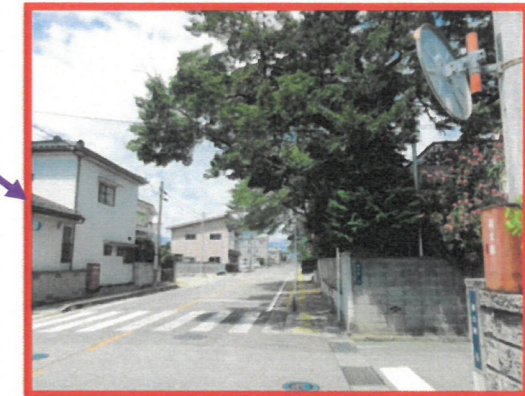
●長く伸び、道路にせり出した樹木 (倒木の恐れあり)
